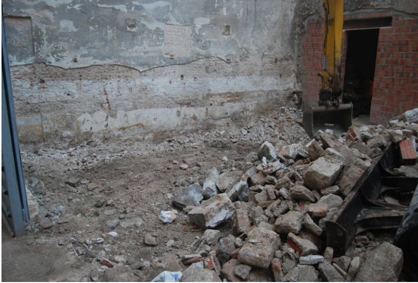
Fotografia núm. 7: neteja de la runa resultant
