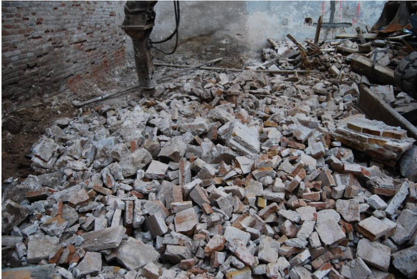
Fotografia núm. 3: desmantellament dels paviments
