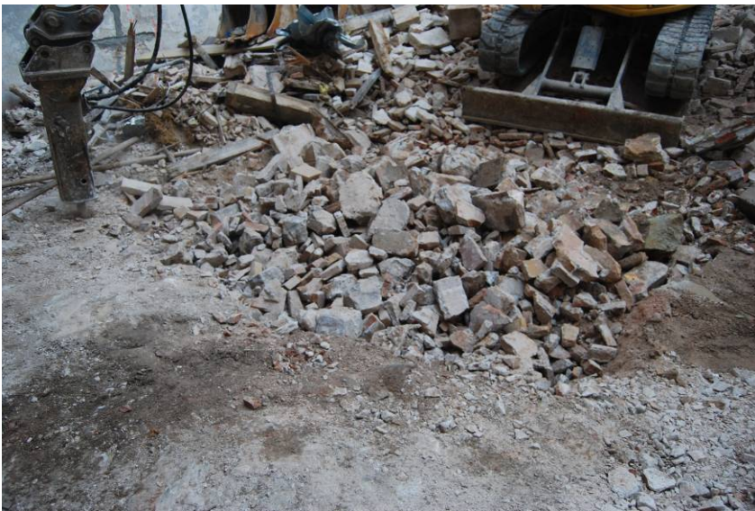
Fotografia núm. 6: desmantellament dels paviments
