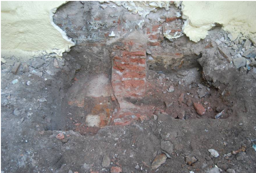
Fotografia núm. 26: cala 5 un cop realitzada
