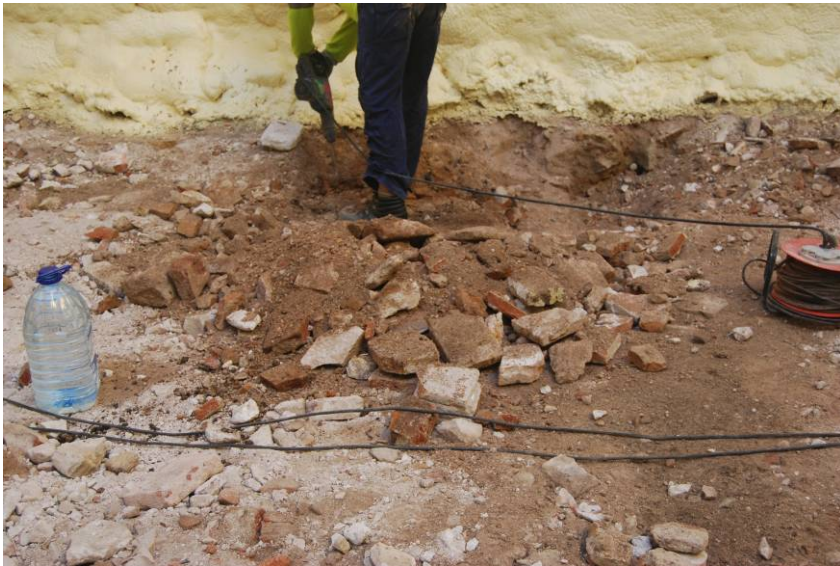
Fotografia núm. 20: execució de la cala 3
