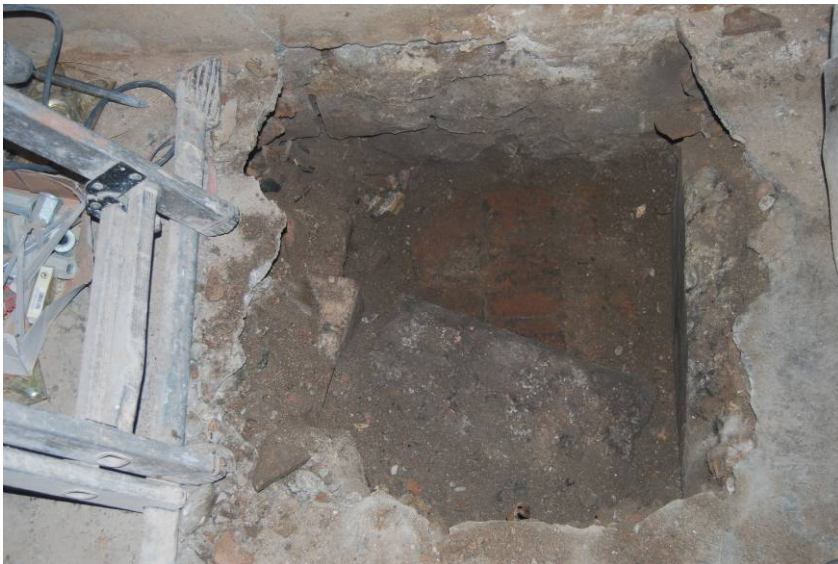
Fotografia núm. 28: cala 6 un cop realitzada
