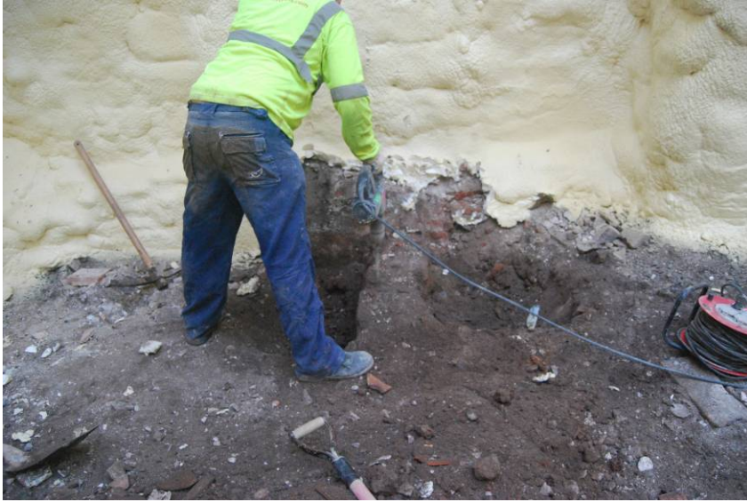
Fotografia núm. 25: execució de la cala 5
