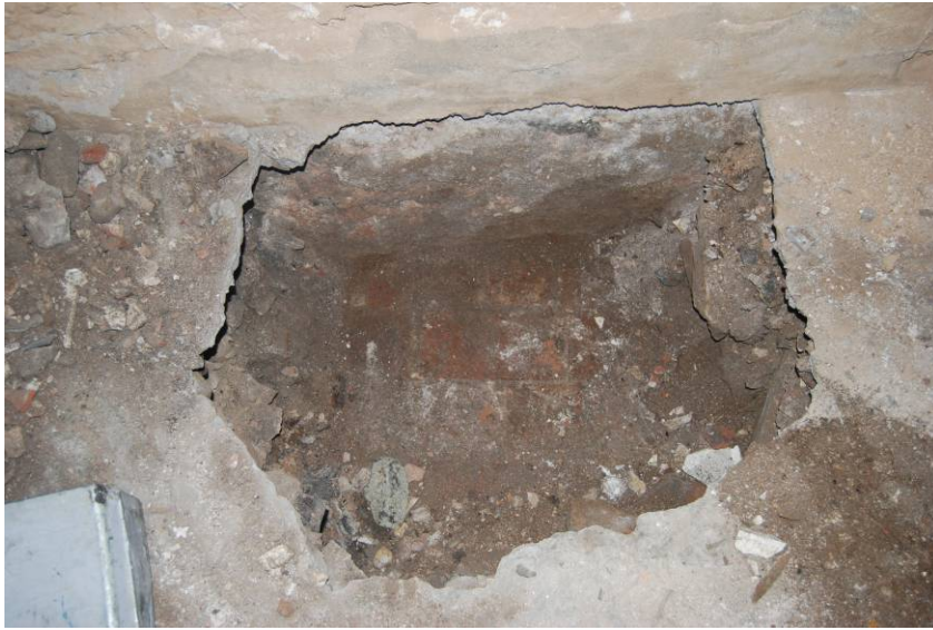
Fotografia núm. 29: cala 7 un cop realitzada
