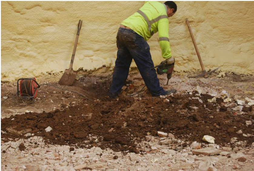
Fotografia núm. 22: realització de la cala 4
