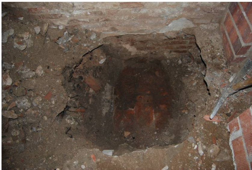
Fotografia núm. 30: cala 8 un cop realitzada
