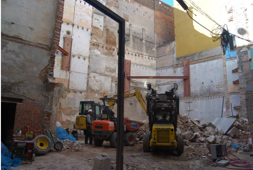
Fotografia núm. 1: vista del solar a l'inici de la intervenció
