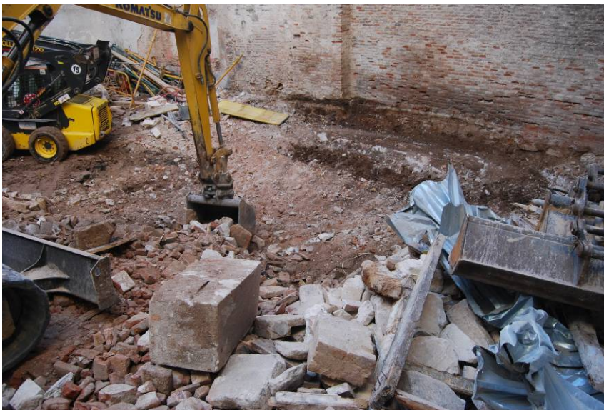
Fotografia núm. 4: neteja de la runa resultant
