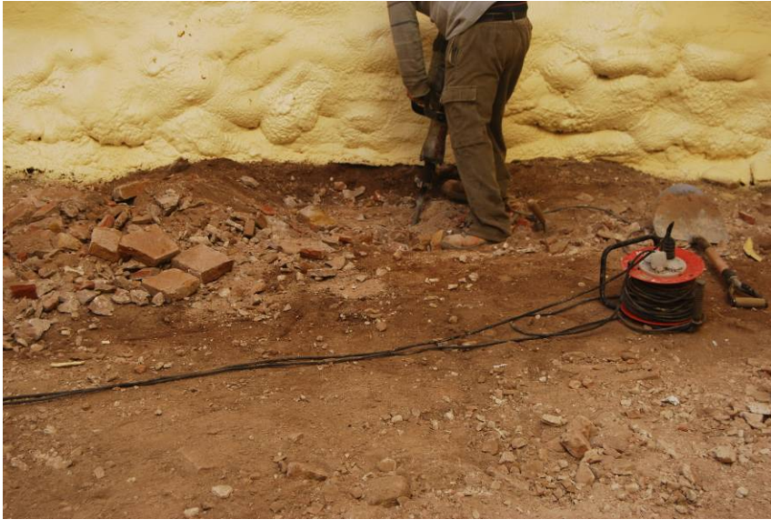
Fotografia núm. 17: execució de la cala 2
