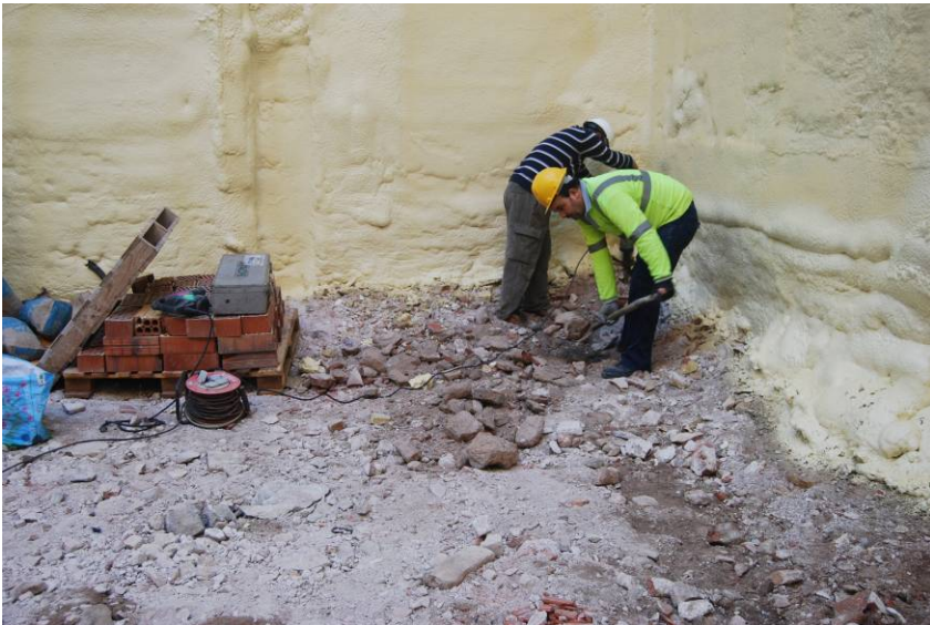
Fotografia núm. 14: execució de la cala 1
