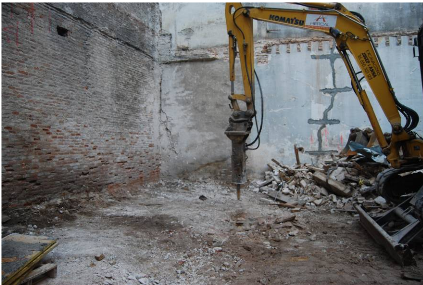
Fotografia núm. 2: desmantellament dels paviments
