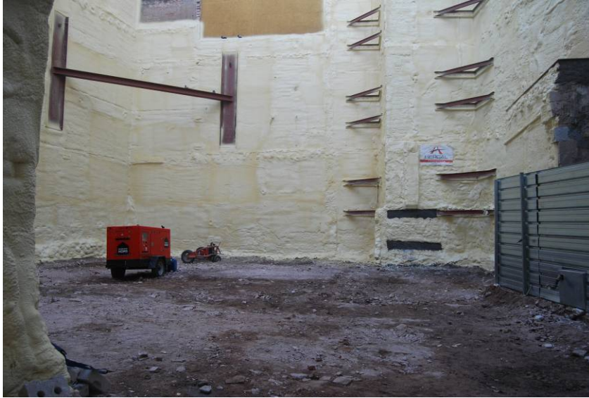
Fotografia núm. 11: el solar un cop anivellat amb el carrer
